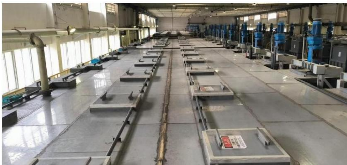
图 7.1.2-2 同类型项目萃取箱现场照片
